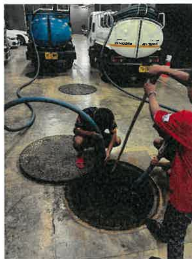
ตักไขมัน และสูบน้ำจากระบบบำบัดน้ำเสีย
