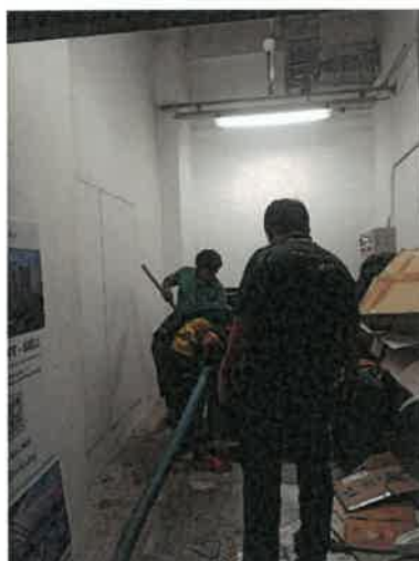
ตักไขมัน และสูบน้ำจากระบบบำบัดน้ำเสีย
