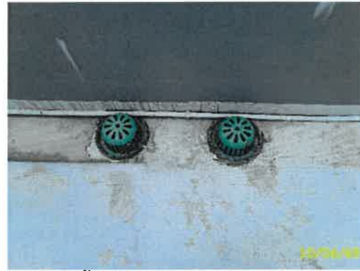
ภาพที่ 2.2-21 ตะแกรงครอบท่อระบายน้ำโครงการ
