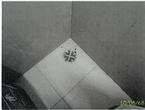
ภาพที่ 2.2-21 ตะแกรงครอบท่อระบายน้ำโครงการ
