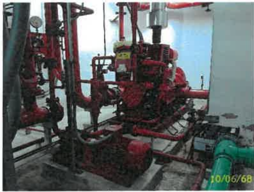
เครื่องสูบน้ำดับเพลิงขึ้นใต้ดิน
